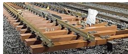
Fig. 4: ESLON neo lumber (FFU) composite sleeper
